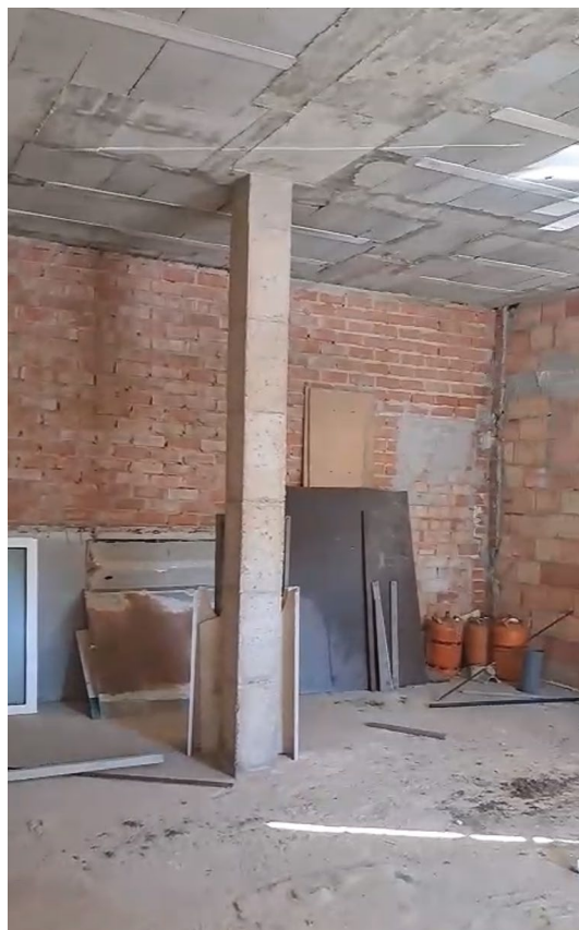
FOTOGRAFÍA 3: Vista del interior del local.
