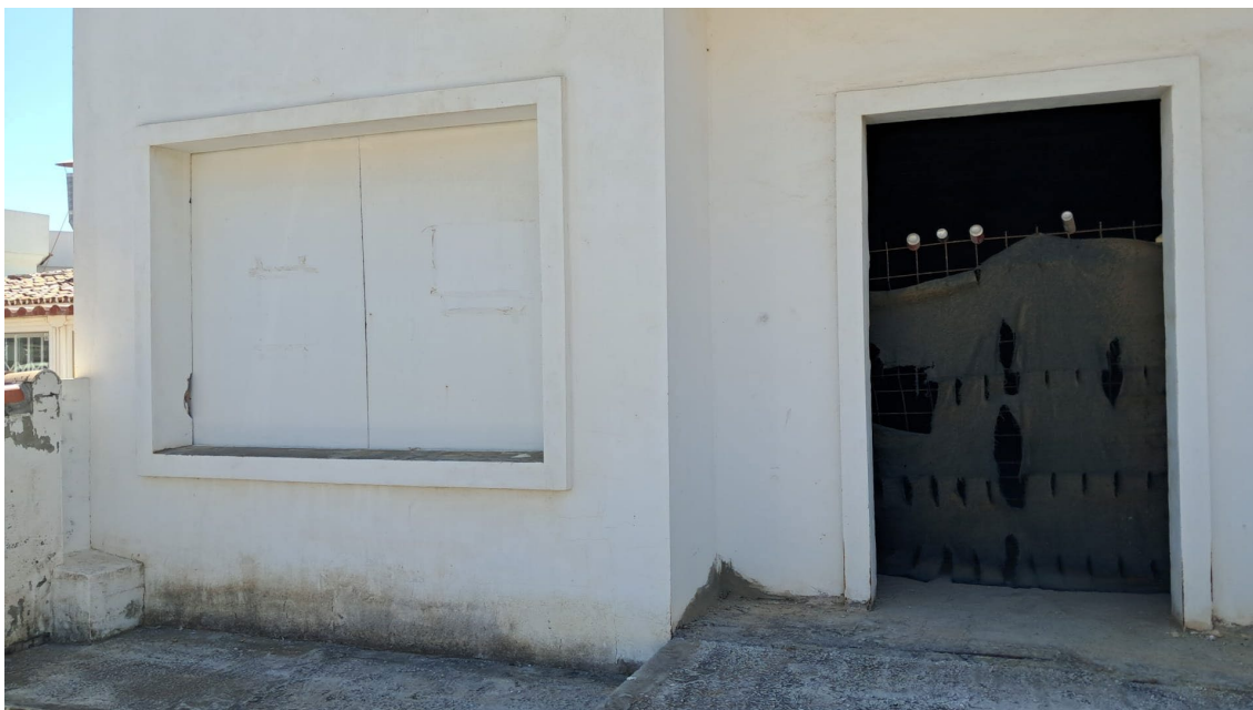
FOTOGRAFÍA 1: Fachada principal del local.
