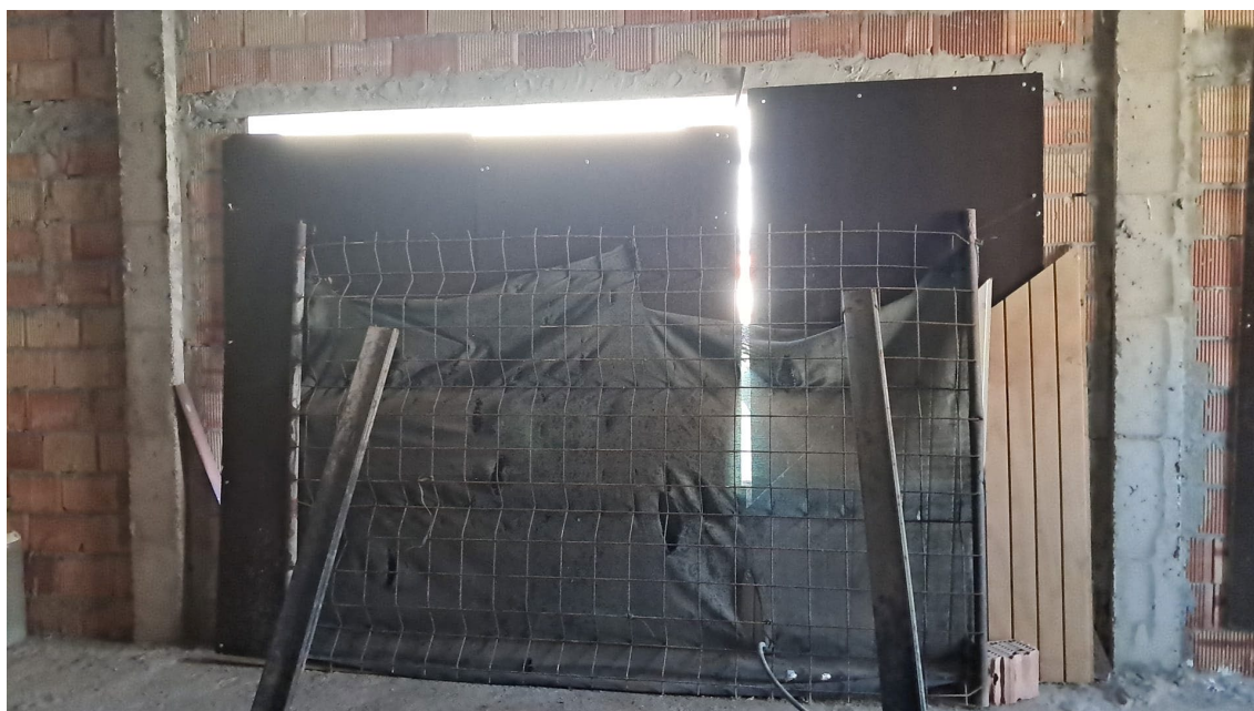
FOTOGRAFÍA 4: Vista del interior del local.
