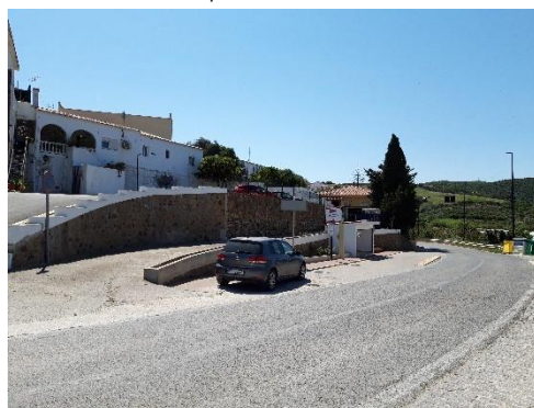
Parada de autobús metropolitano en Guadiaro, en zona de escasa visibilidad, en un entorno no accesible y alejada de los pasos peatonales
