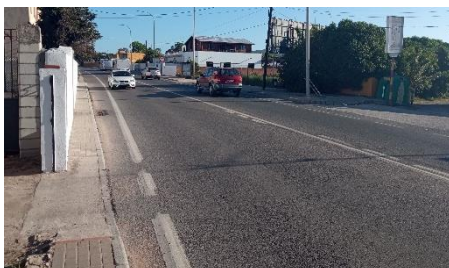
Falta de accesibilidad en C/ Real, Campamento
