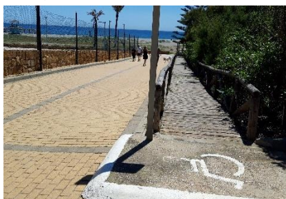
Acceso para PMR a la playa desde el aparcamiento
