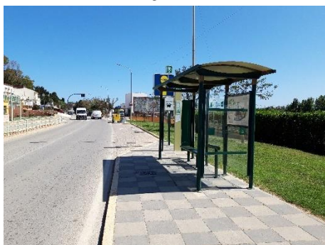
Parada de autobús metropolitano con entorno no accesible en San Enrique de Guadiaro
