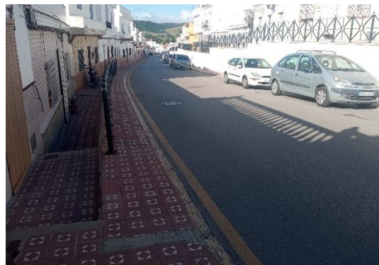
Escaleras en las aceras
