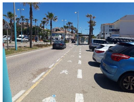
Itinerario peatonal con urbanismo táctico en Torreguadiaro
