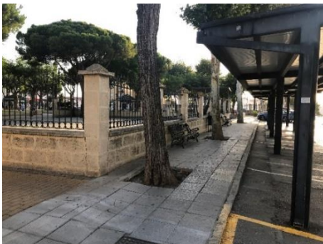
Falta de accesibilidad en el entorno de la parada de taxis en la Alameda de Alfonso XI
