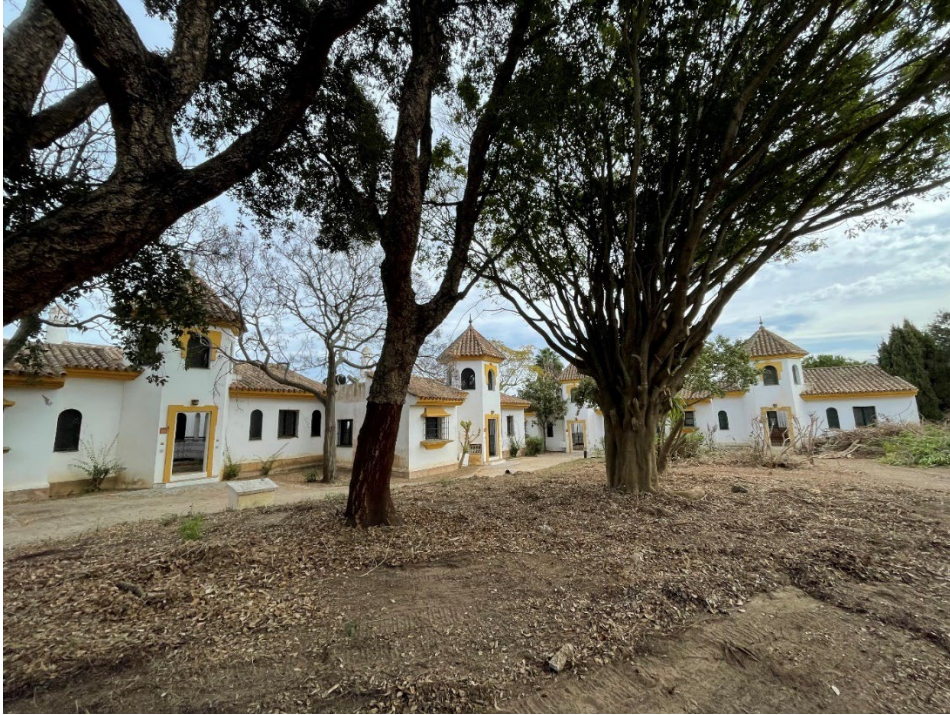
Vista general de las villas (habitaciones del hotel).
