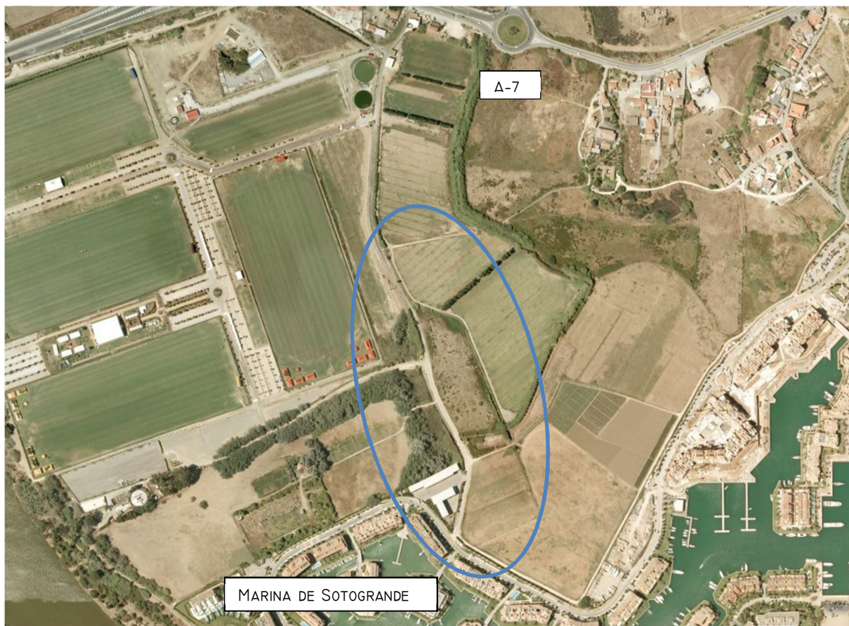
Vista general del tramo del camino objeto del Proyecto
