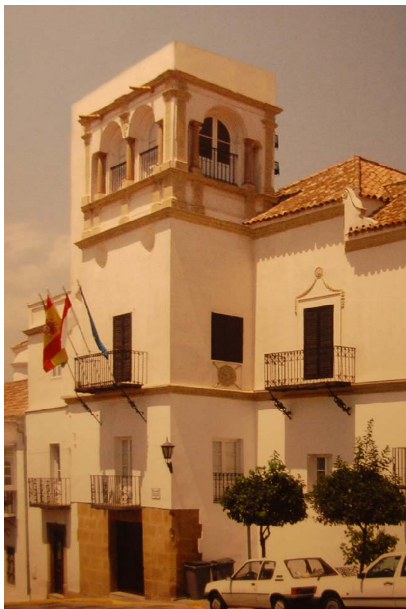
F.55 Torreón del Palacio de los Gobernadores
