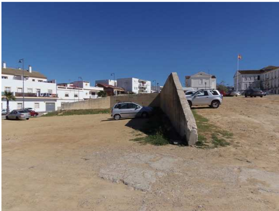
VISTA DEL MURO DE HORMIGÓN DESDE FACHADA OESTE
