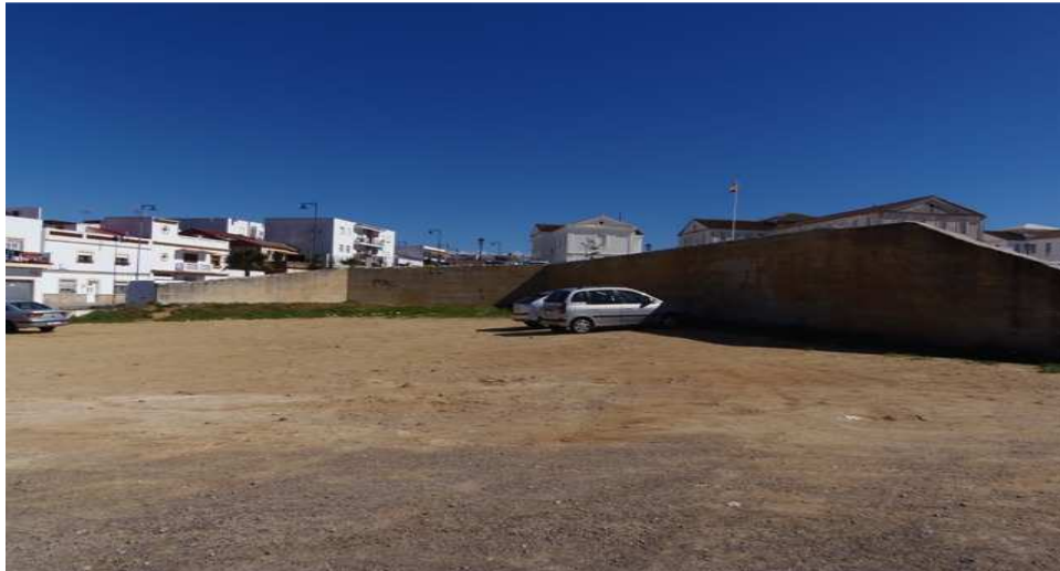
VISTA DEL MURO DE HORMIGÓN DESDE ESQUINA NOROESTE
