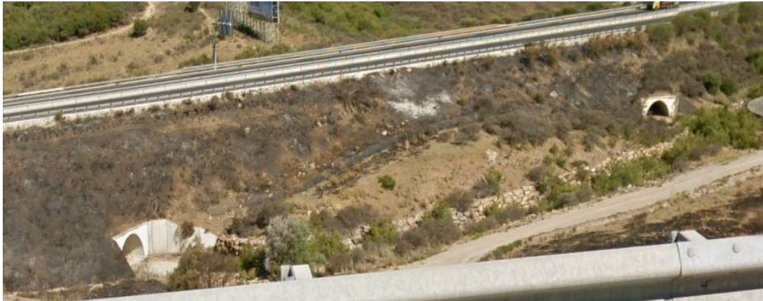
Figura 12. Obras de paso en la AP-7
