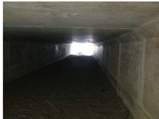
Figura 13. Sección de entrada e interior de la obra de paso del ramal a Torreguadiaro
